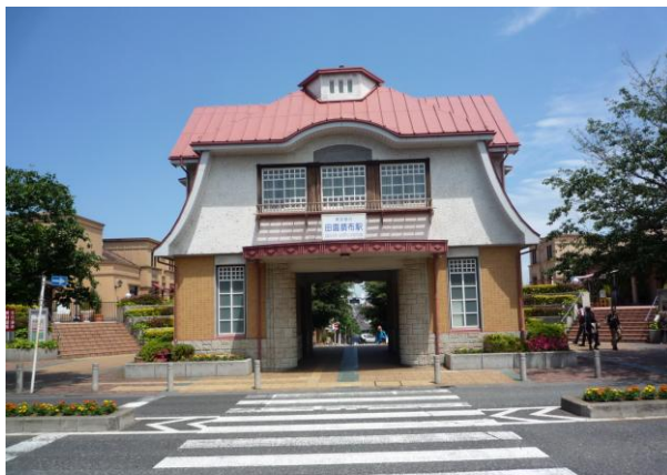
東急東横線「田園調布」駅舎
